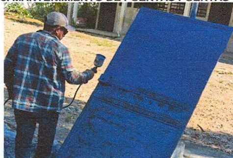
Foto 6: Se observa el lijado y posterior aplicación de pintura a las puertas de tres aulas.
