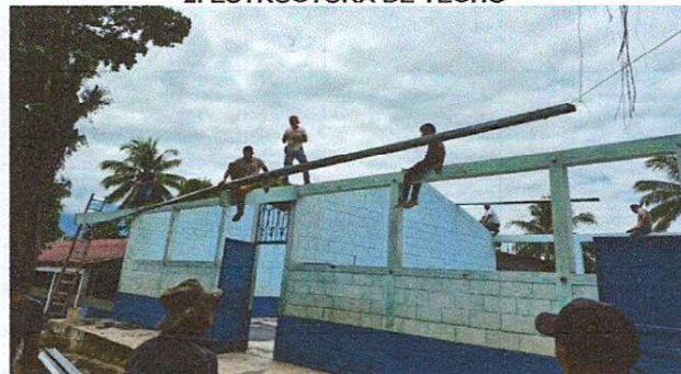
Foto 2: Se observa el momento en que las costaneras de metal anterior son reemplazadas en su totalidad por costaneras nuevas.
