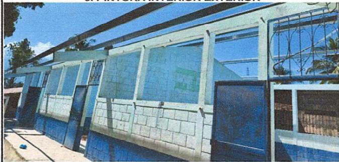
Foto 5: Se observa el momento en que son limpiadas y lavadas las paredes del interior y exterior para su posterior aplicación de pintura.
