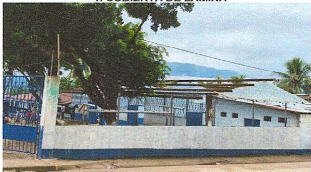
Foto1: Se observa el momento en la cual son bajadas todas la cubierta de techo, para después ser reemplazadas por láminas troqueladas calibre 26.
