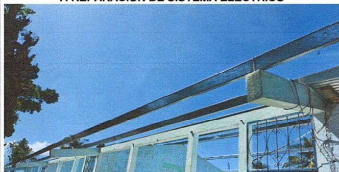
Foto 4: El cableado electrico es retirado en su totalidad para después ser reemplados por nuevos materiales y nueva instalación.
