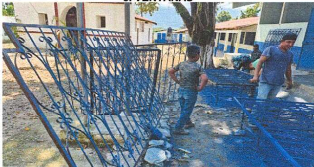
Foto 3: En esta imagen se aprecia el día en que fueron removidos los balcones para luego aplicarle pintura posterior a quitarle el oxido y otros sustancias.
